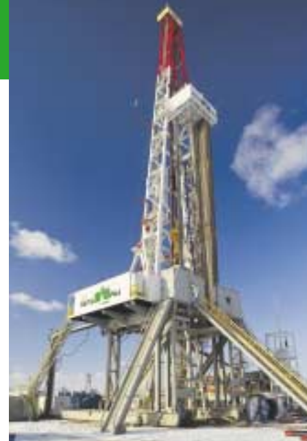
IDM 2000 – najnowocześniejsze w Polsce urządzenie wiertnicze, które może wykonać otwór na głębokość ok. 8500 m. To również przykład, że ingerencja w środowisko naturalne przy pracach wiertniczych jest niewielka, ograniczona do niezbędnego terenu.
