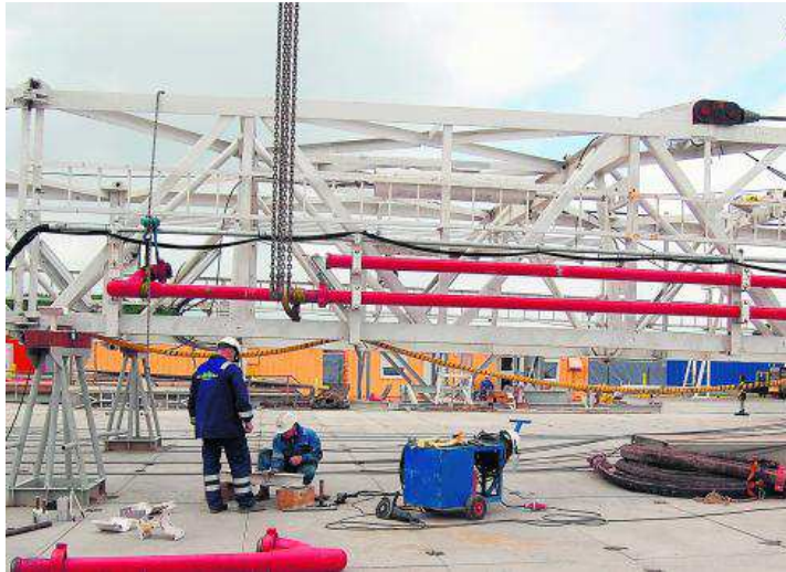
Do Łebienia z Piły przyjechała wieża wiertnicza oraz kilkunastoosobowy zespół obsługi
